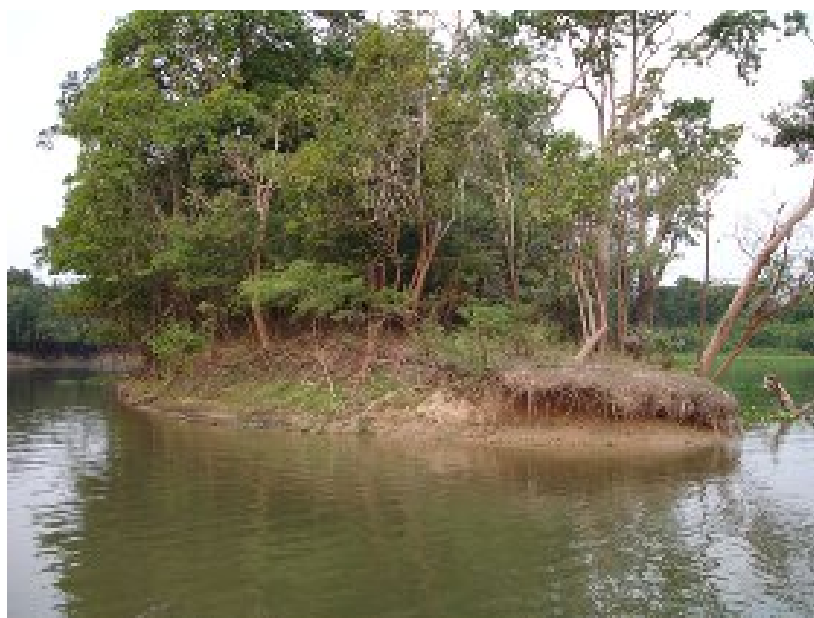
Figura 2 - Aspecto de erosão hídrica no rio Guaporé, Costa Marques, Rondônia. Setembro de 2010
